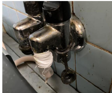
コンセント型ガス栓とソフトコードとの接続状況
