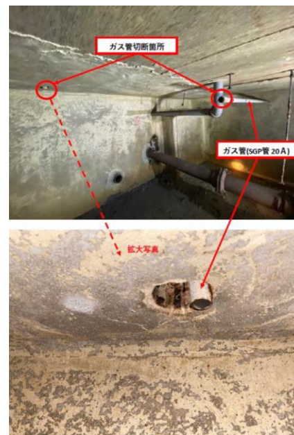
床下ピット内
