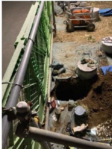
地境切断掘削口
