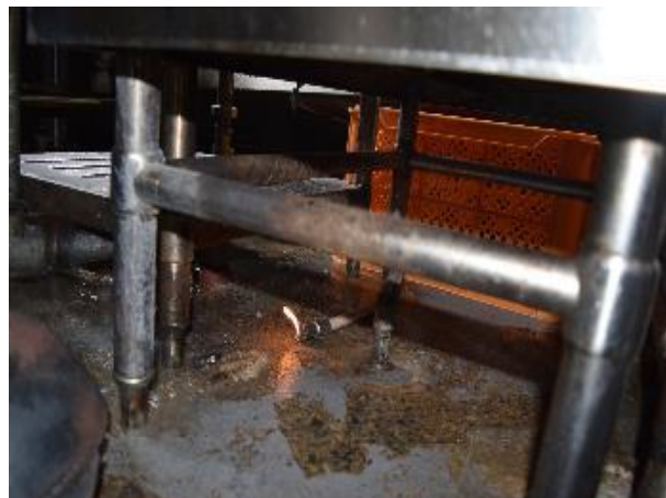
燃焼器ホース先端から火が噴いている
