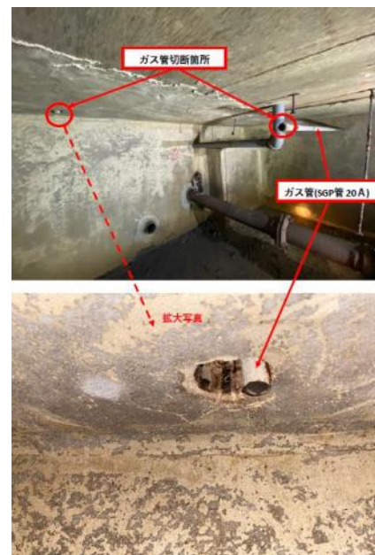
床下ピット内
