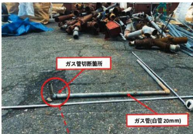
切断されたと思われるガス管
