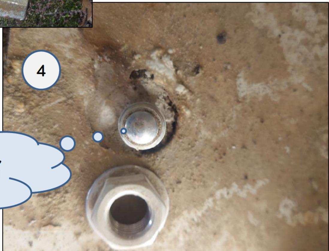
バルク貯槽アンカー部の穴が大きくボルトサイズと合っていないため、完全締結できずゆるみが生じた事例
