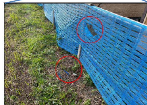
飛石による破損箇所（敷地外）
