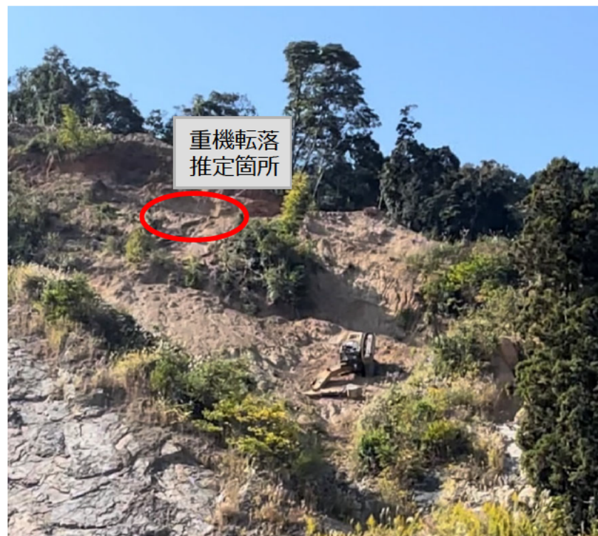
災害発生箇所付近の状況
