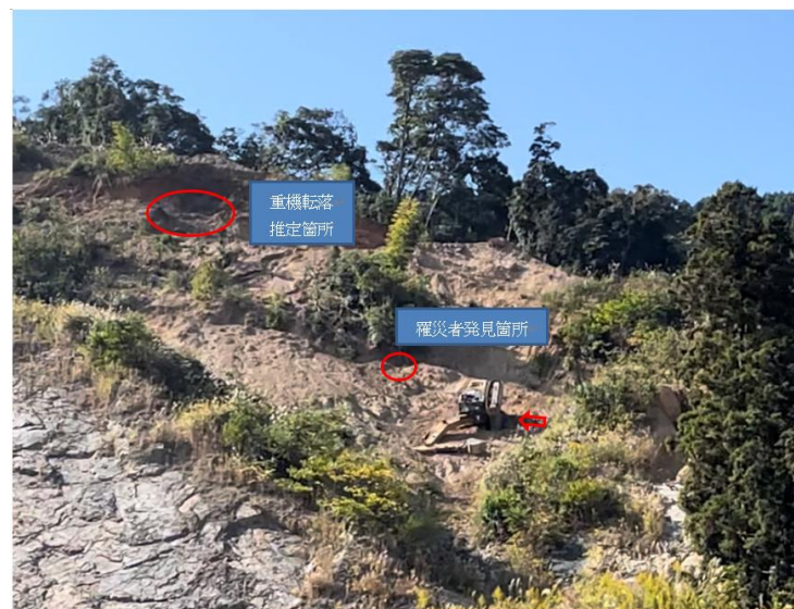
災害発生箇所付近の状況
