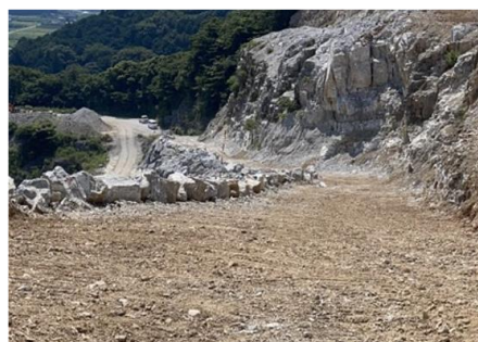
谷側に転落防止設備を設置
