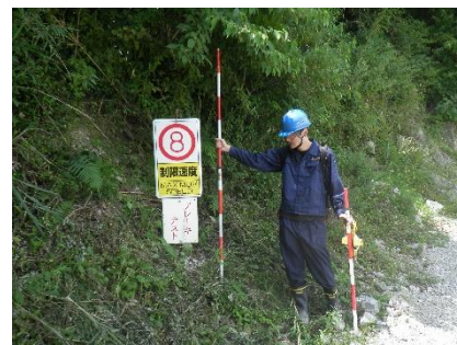
鉱山道路入口に看板を設置
