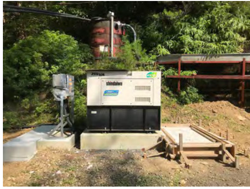
第2堆石場（25kVA）
