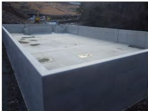
施工後の浸透水貯水ピット
