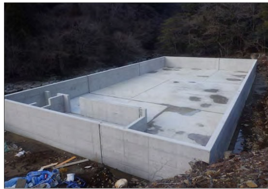
施工後の浸透水貯水ピット
