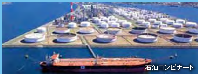
高圧ガス製造施設
