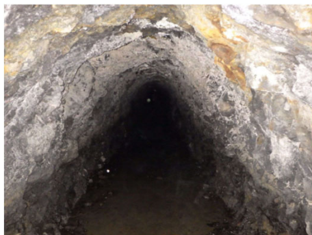
導水路（コンクリートで巻いていない岩盤部分）
