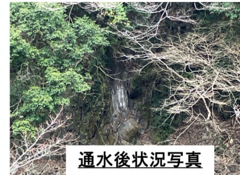
漏水箇所（補修後）
