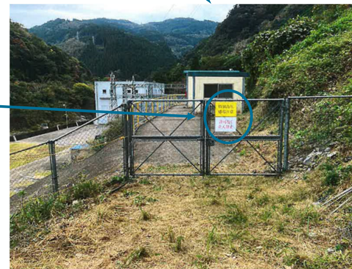
変電設備入口ゲートを拡張
