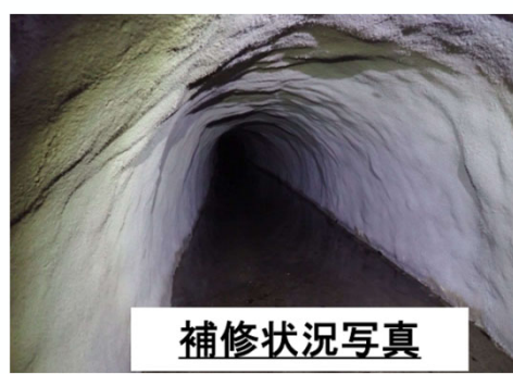
補修（モルタル吹付巻立）
