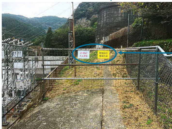
通路にゲートを設置
