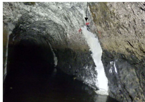
補修（止水モルタル）
