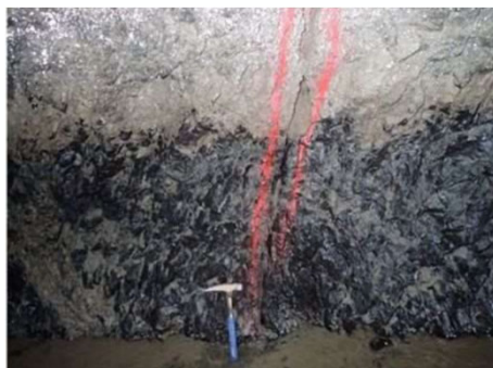
岩盤のクラック
