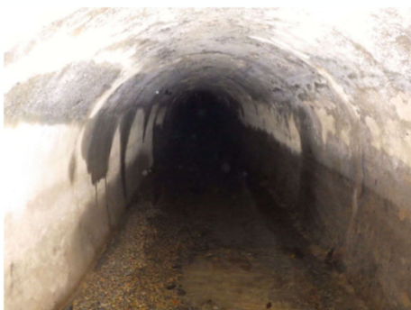
導水路コンクリート巻立部
