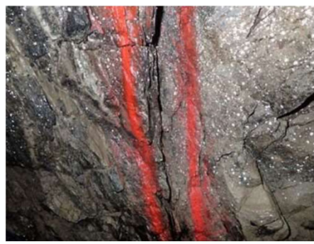
岩盤のクラック（拡大）
