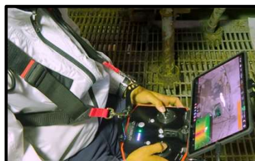
〔 ボイラー炉外からの操縦 〕
