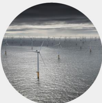
洋上風力発電設備
