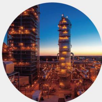
CO2回収設備
