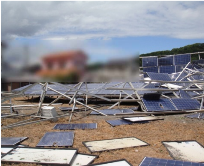
パネル飛散の例 (昨年8月 台風15号によるもの)
