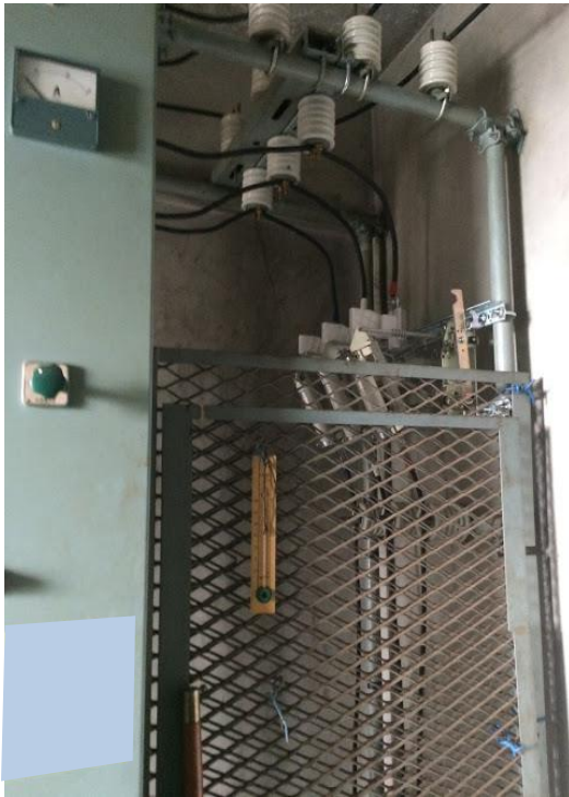
電気室内のフェンスの状況
